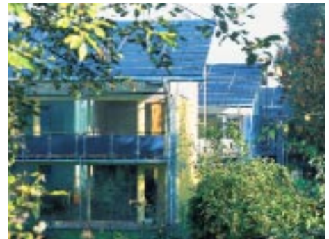
Abb. 2: In der »Solarsiedlung Schlierberg« speisen ca. 130 Wechselrichter den Strom von etwa 330 kWp Photovoltaik in das Niederspannungsnetz ein. (Foto: Andreas Weindel)
