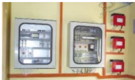
Abb. 2: Blick in den Technikraum mit Schaltschränken und Wechselrichtern. In den Schaltschränken befinden sich neben einem Teil der Wechselrichter auch die Datenlogger und alle Energiezähler.
