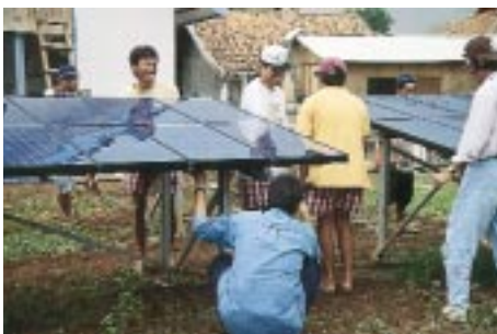
Abb. 1: Installation einer PV-Hybridanlage in Indonesien.
