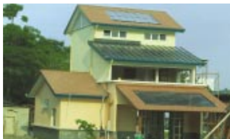
Abb. 1: Blick auf das »Prototyp Solarhaus«. Auf dem oberen Dach befinden sich die Standard-Silicium-Module, auf dem mittleren Dach die Si-Dünnschichtmodule und auf dem unteren Dach die Dachziegel mit polykristallinen Zellen.
