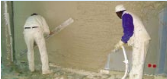
Abb. 1: Einbringen des PCM-Putzes in den Neubau des Energieversorgers badenova in Offenburg. Die Handhabung des Materials auf der Baustelle unterscheidet sich nicht von der eines herkömmlichen Gipsputzes.
