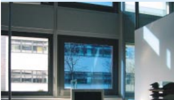
Abb. 2: Blick aus einem Fraunhofer ISE-Büro mit schaltbarer Verglasung. Die rechte Scheibe ist blau eingefärbt. Das linke Fenster steht offen. Selbst im tief eingefärbten Zustand mit einem Gesamtenergiedurchlassgrad um 15% bleibt die Durchsicht erhalten.
