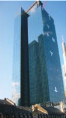
Abb. 1: Das neue Hochhaus der Dresdner Bank in Frankfurt (Main). Die einschalige Fassade ermöglicht die natürliche Belüftung der Räume. Eine einschalige Fassade ist nicht nur wegen der Investitionskosten wirtschaftlich, sondern auch, weil der vermietbare Raum wegen der geringeren Wanddicke größer ist.
