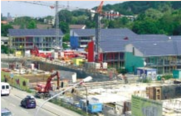
Abb. 1: In dieser Solarsiedlung in Freiburg sind derzeit etwa 40 Wohneinheiten mit zusammen etwa 260 kWp Photovoltaik in Betrieb. Circa 100 dezentrale Wechselrichter speisen den Solarstrom in das Niederspannungsnetz.
