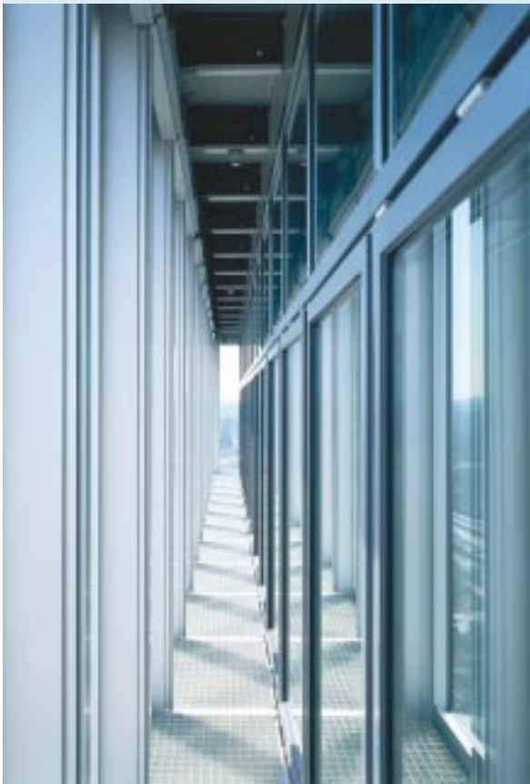
Abb. 1: Im stark verglasten Fraunhofer-Haus (17 Stockwerke) in München kann der Kühlenergiebedarf für die Bauteilkühlung durch Nutzung natürlicher Wärmesenken (kühle Nachtluft) stark reduziert werden, da die Doppelfassade eine freie Tag- und Nachtlüftung möglich macht. Das Bild zeigt den Blick in ein Stockwerk der nach Süd-Osten orientierten Doppelfassade.
