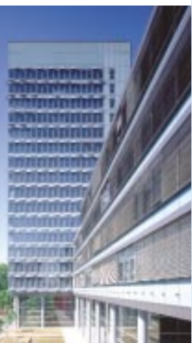
Abb. 3: Das Fraunhofer-Haus in München. Die Fassade ist doppelschalig ausgeführt und wird zur Belüftung der Büros verwendet.
