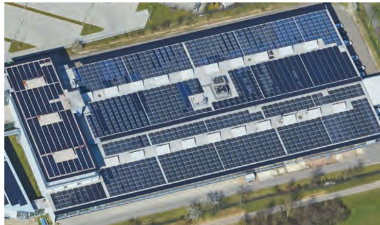
Vogelperspektive auf das neue Zentrum für elektrische Energiespeicher im Freiburger Industriegebiet Haid.
