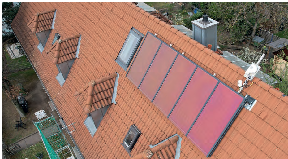
Pilotinstallation mit farbigen, solarthermischen Kollektoren in Freiburg St. Georgen.
