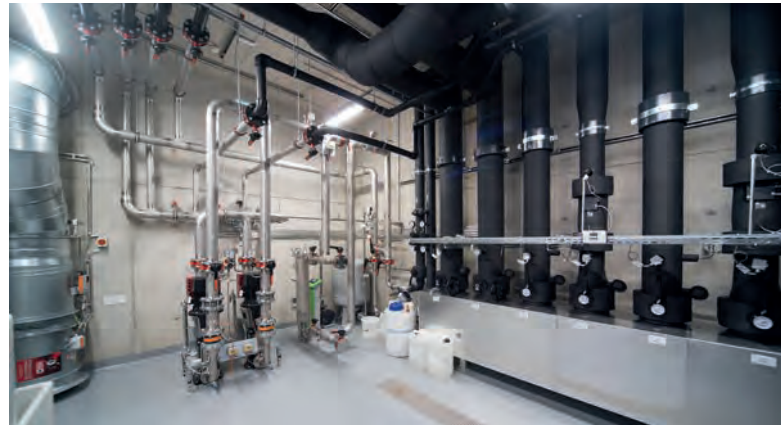
Fotografische Erfassung von Bestandsanlagen.
